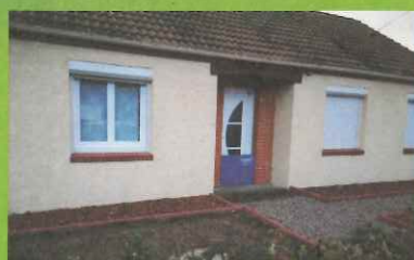
> Photo batardeaux : Barrière anti-inondation installée à Recques sur Hem
